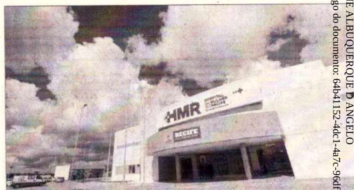
O espaço do ambulatorio, que abrigou uma das enfermarias de covid-19 instaladas provisoriamente na unidade, funcionará com 50% de sua capacidade de atendimento
